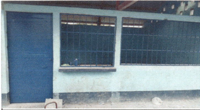
Foto1: se observa la finalización de colocación de balcones.
