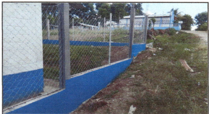
Foto 4: Se observa la finalización del cerco perimetral.
