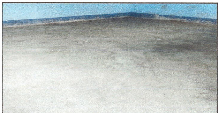
Foto 6: Se observa la finalización del piso
