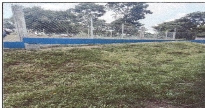
Foto 5: Se observa la finalización del cerco perimetral.
