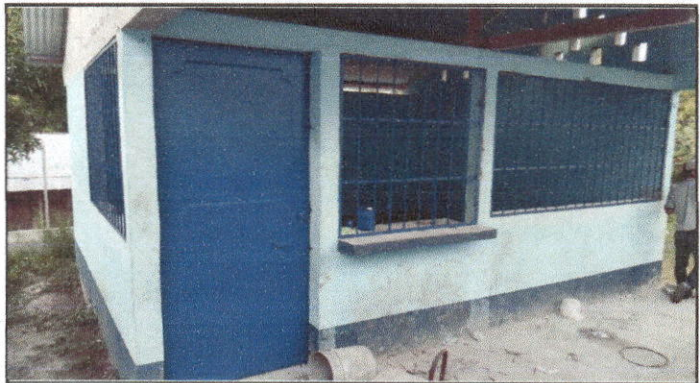
Foto 2: Se observa la finalización de colocación de puerta.
