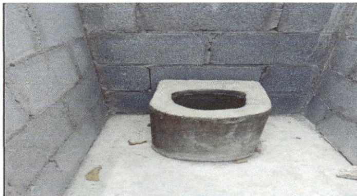
Foto 3: Se observa la finalización del baño.
